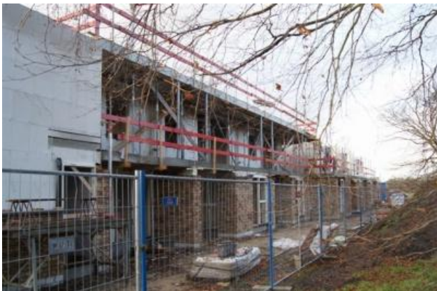
Bouw van de Beukenhof vordert voorspoedig
