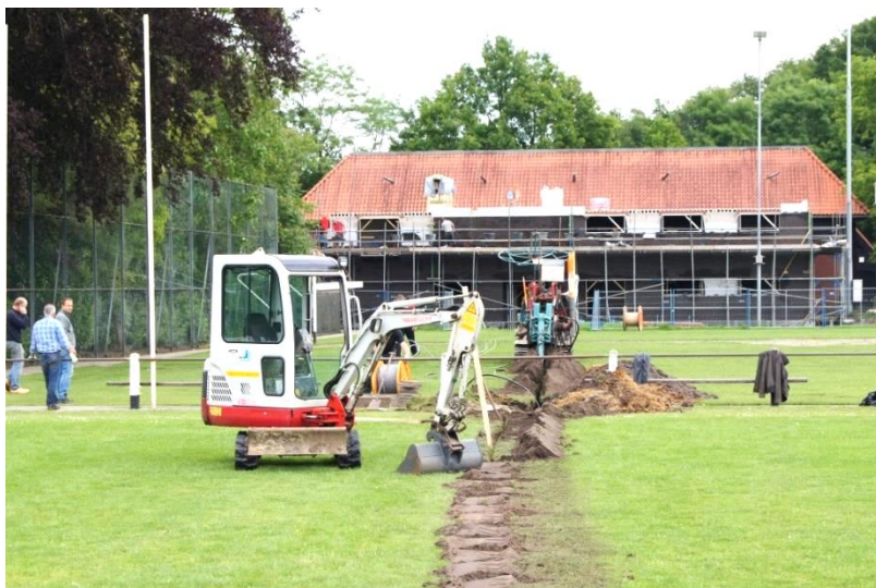
De bouw van de kledkamers is op hoogte (zie achtergrond) en kabels worden getrokken door velden 2 en 1 voor nieuwe aansluitingen van stroom en water bij de tribune en verlichting van veld 3.
