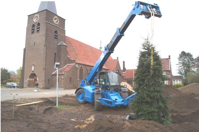
De nieuwe kerstboom werd geplaatst in de grondig gerenoveerde pastorietaan
