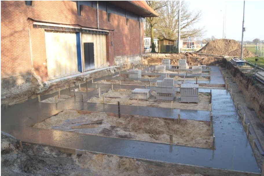
En vijf dagen later was het beton in de fundering gestort
